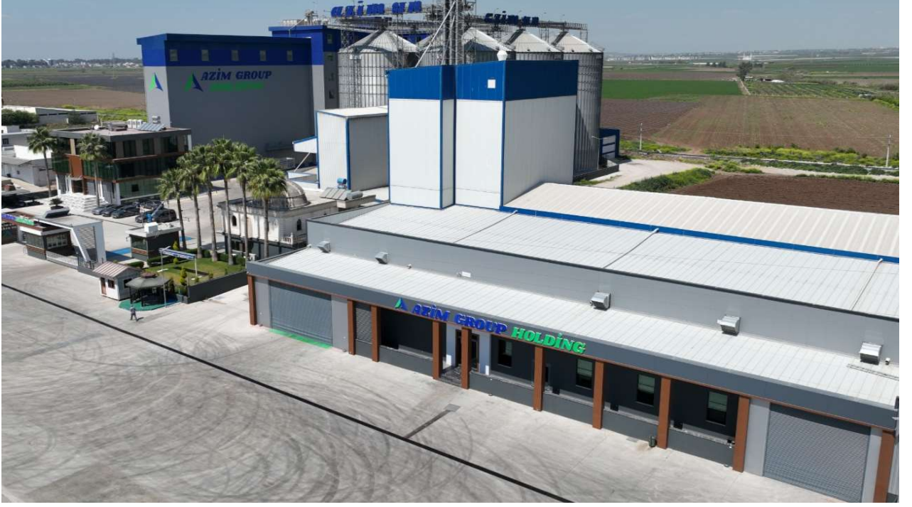
Akhan Un - Adana Fabrikası
